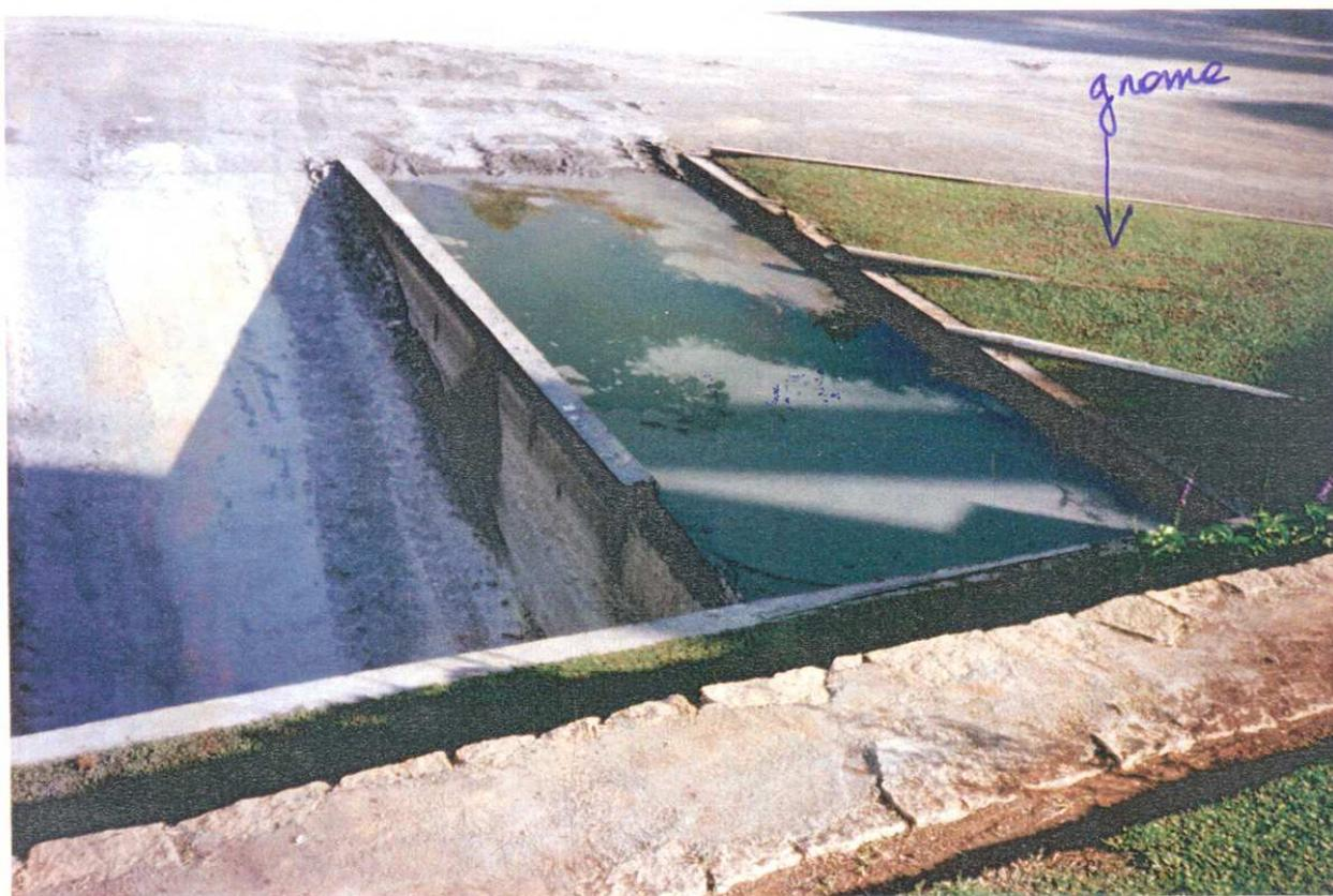
Foto 2 - Sistema de Decantação composto de três tanques, visto de cima, observa-se o plantio de grama para controlar a queima de vegetação
