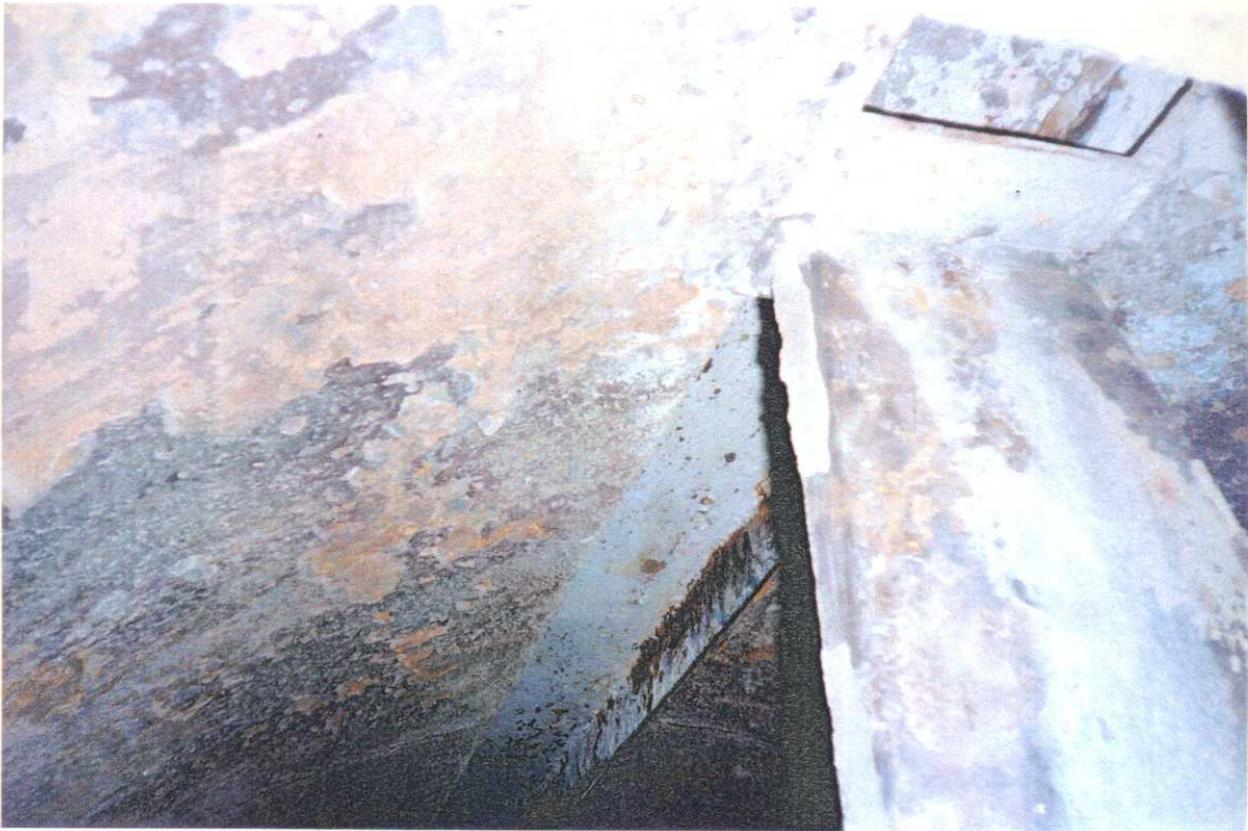
Foto 6 - Interior do lavador de gases, observa-se a corrosão por gases ácidos
