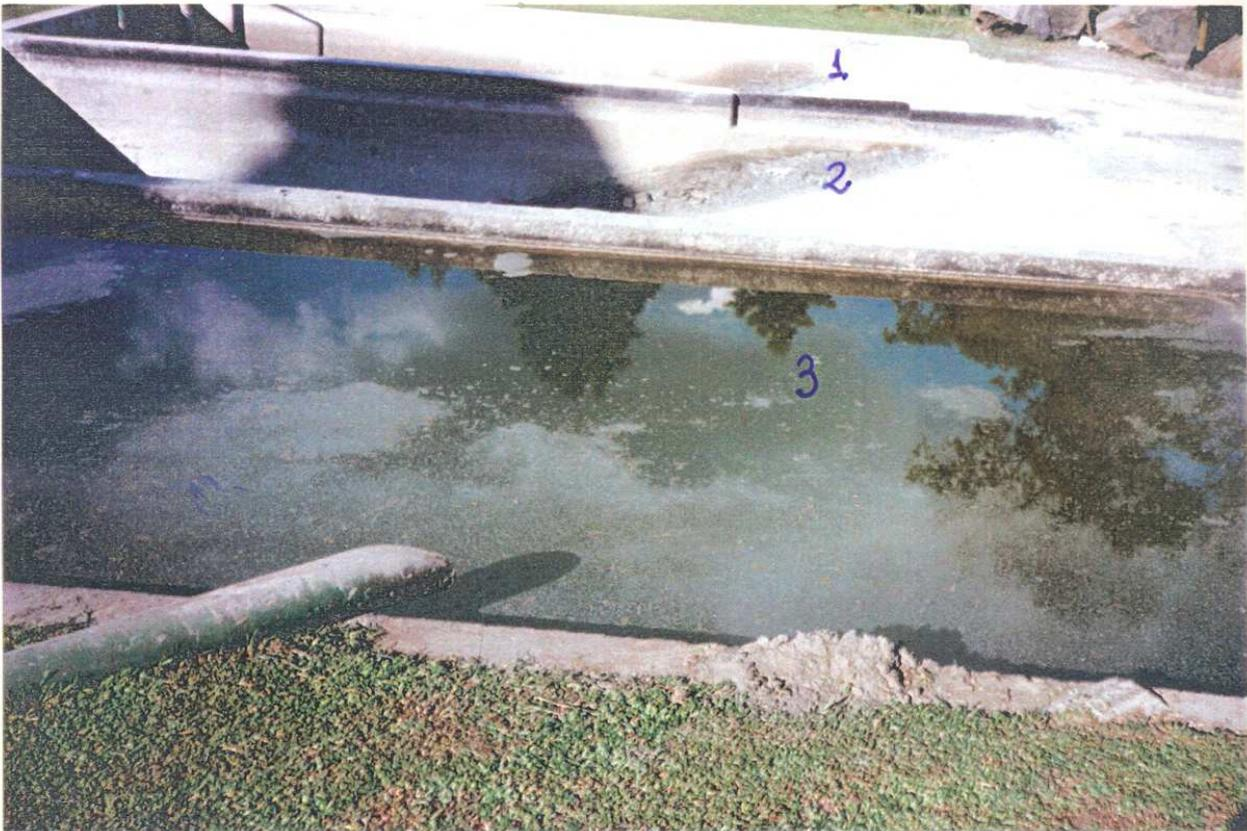
Foto 1 - Sistema de Decantação composto de três tanques
