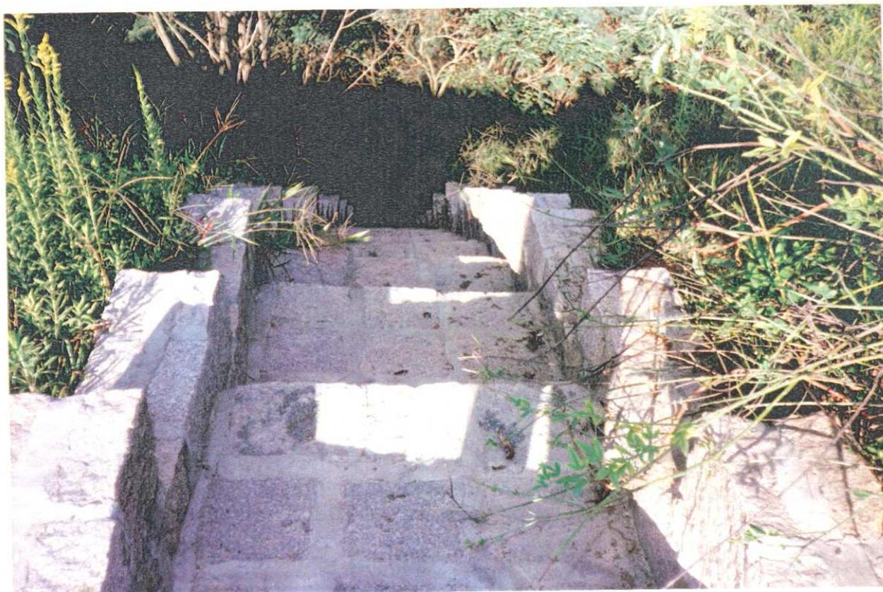
Foto 11 - Sistema de Escada para minimizar a erosão das águas pluviais
